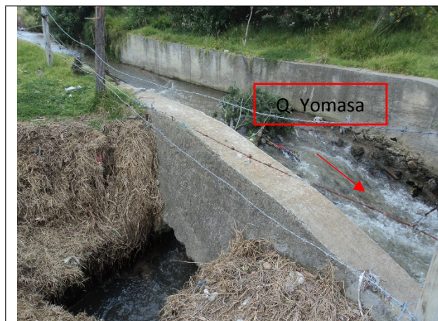
Foto No. 11. Ruptura de la pared lateral para la derivación del caudal de la Quebrada Yomasa por el predio Cantarrana. (Punto 7 - Imagen 3).
